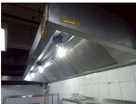
ภาพที่ 17 เครื่องดูดกลิ่นและควันในครัว
