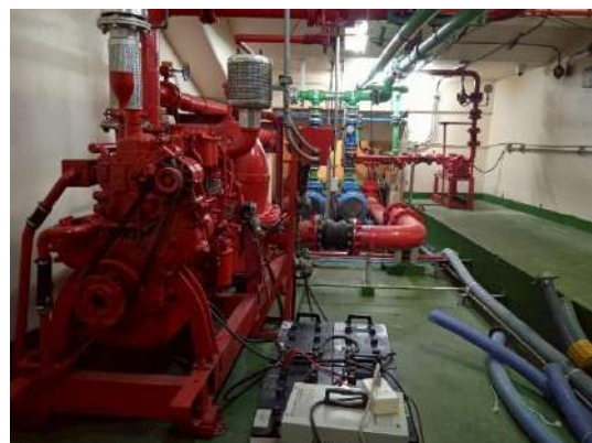
ภาพที่ 30 ปัมป์สูบน้ำดับเพลิง
